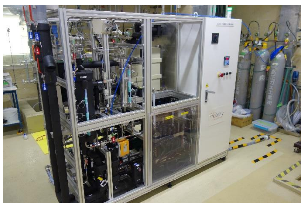
水電解水素発生装置
